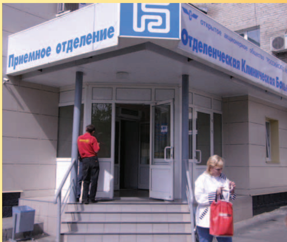
Приемное отделение Железнодорожной больницы Барнаула.
