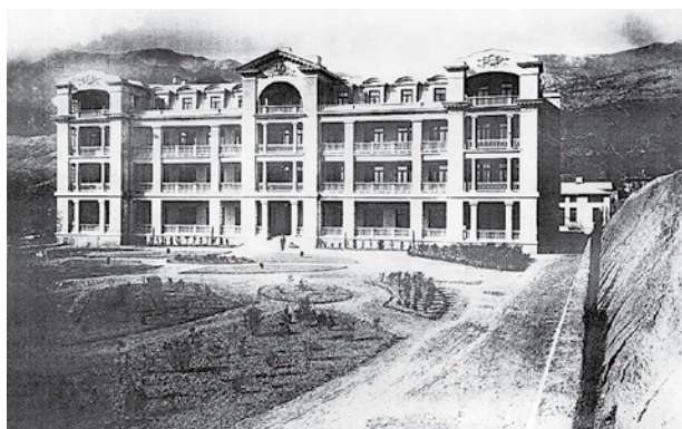
ЗДАНИЕ ЯЛТИНСКОГО ПРОТИВОТУБЕРКУЛЕЗНОГО САНАТОРИЯ (НАЧАЛО XX ВЕКА). СЕЙЧАС ГЛАВНЫЙ КОРПУС ИНСТИТУТА ИМ. И.М. СЕЧЕНОВА
